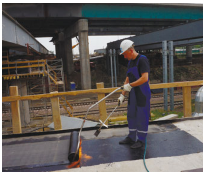
Рис.12 Наплавление гидроизоляционного материала
